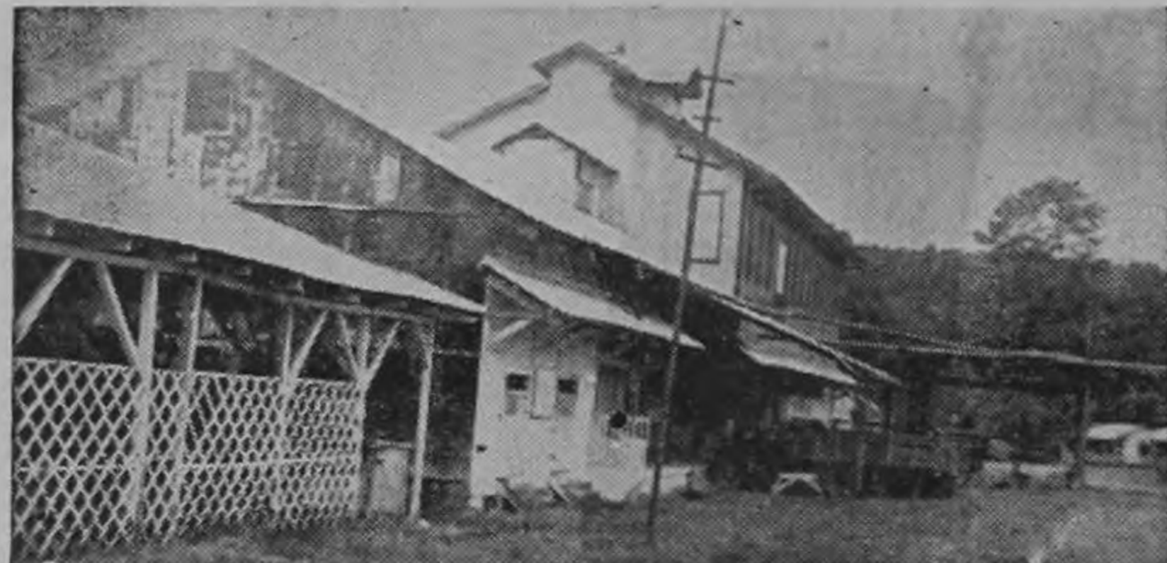
Vista parcial de algunas de las instalaciones de la Hacienda Pejiballe. En primer plano se aprecia el galerón del aserradero, equipado con una sierra circular de 60", con motor eléctrico de 60 H. P.; cepilladora, recortadora circular, canteadora y atiladora de cuchillas. Seguidamente se aprecia una de las muchas bodegas para el almacenamiento de café y finalmente el beneficio con capacidad para 20.000 fanegas de café por temporada, con equipos modernos que incluyen sistema de lavado automático del grano
