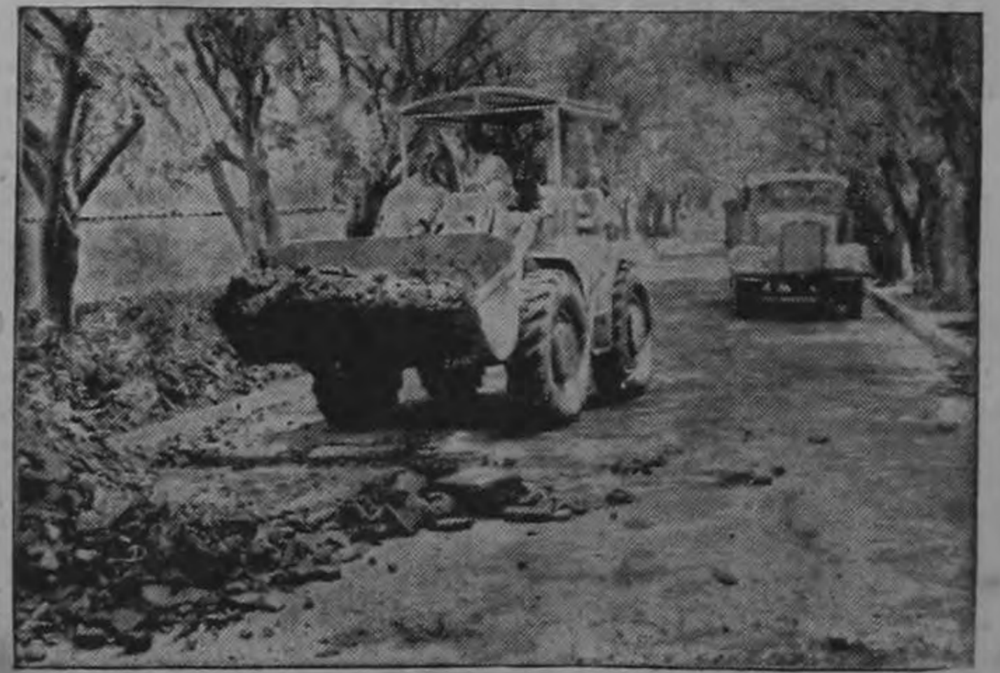
Equipo levantando la carpeta asfáltica oxidada. Operación salvamento de calles. Avenida 3, Calles 5 hasta la 23, por la que transitan los autobuses de San Pedro, Guadalupe, Moravia, etcétera
